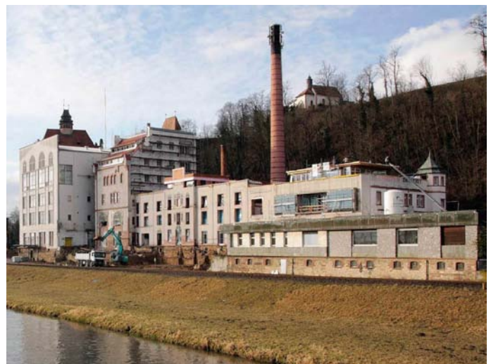
Während Fürstenberg 175 Jahre Riegeler Brautradition feiert, entstehen im ehem. Gebäude in Riegel Lofts und eine Kunsthalle. | Foto: MW
